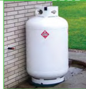
C | RÉSERVOIR DE PROPANE 420 LB
